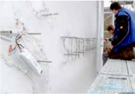
Montage des Schriftzuges auf der Fassade.
